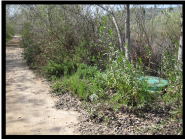
12. Manhole #15 32° 54.57 N 117° 12.49 W
