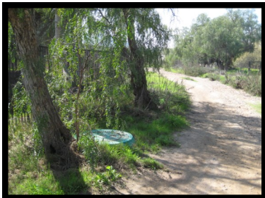
14. Manhole #2 32° 54.48 N 117° 12.66 W
