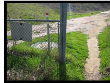
15. Manhole #3 32° 44.45 N 117° 12.70 W
