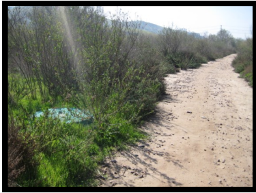
11. Manhole #14 32° 54.62 N 117° 12.42 W
