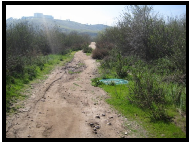
10. Manhole #1 32° 54.75 N 117° 12.35 W
